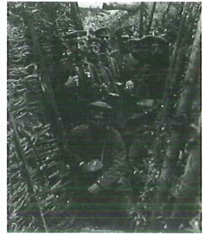
Soldados alemanes en una trinchera.
