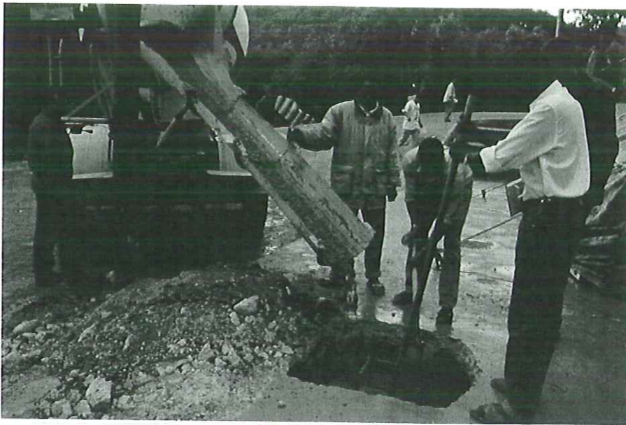
Grupo de personas trabajando en la construcción.
